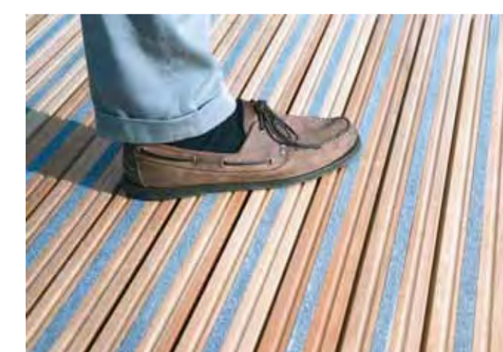
5 Non slip timber decking
